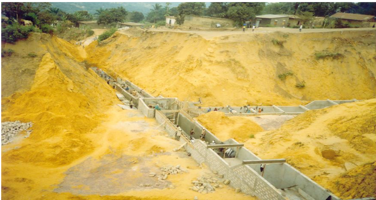
Contrôle et surveillance de la construction de la glissière Mataba I à KINSHASA, longueur : 1300 m
