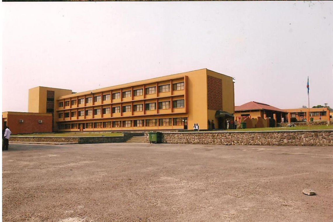
RESCENTE REHABILITATION DE L'IBTP KINSHASA R. D. CONGO
