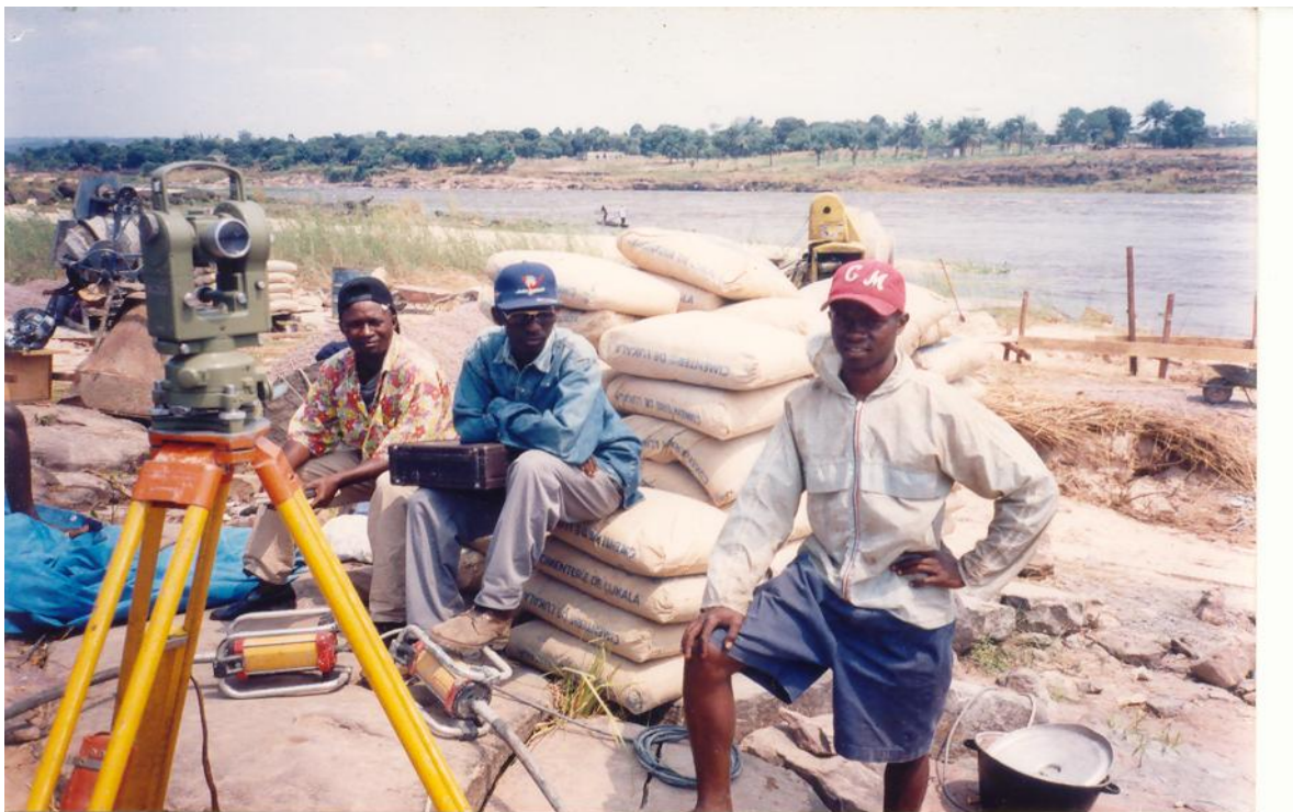
Implantation du Pont Kiwudi à C.P.A
